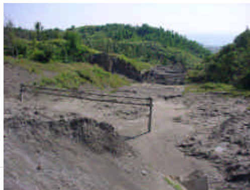
火口、地溝帯が生じた国道230号。1980年の報告書では代替路の必要性が提言されていた。
