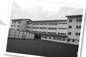
8/26 甲西中学校新校舎棟 完成お祝い式 市内全小中学校の耐震化が完了し、 各中学校にはエアコンが 整備されました。
