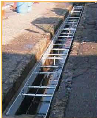
⑤ 流れ止め金具設置完了
