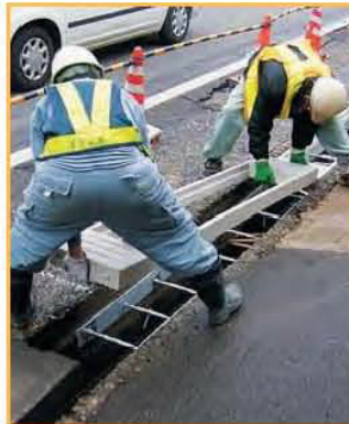
⑥ 一次蓋仮設置
