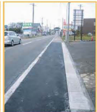
⑫ 新設側溝の様に完成
