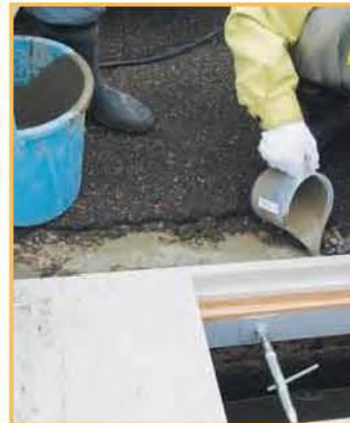
⑦ 充填剤を練り混ぜ注入
