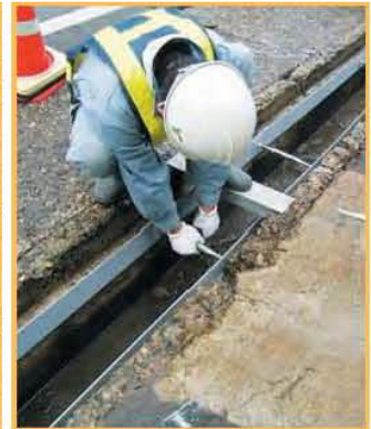
④ 定規で流れ止め金具設置
