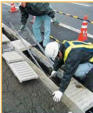
⑨ 流れ止め金具撤去
