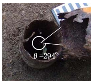
写真5 折損後の破壊断面
