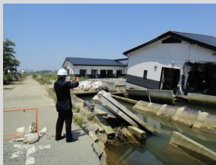
石巻市立病院 地盤沈下がみられる(災害時のままの状況である)
