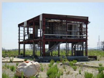
残置する鉄骨造の建築物
