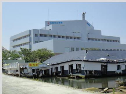
石巻市立病院 地盤沈下がみられる(災害時のままの状況である)
