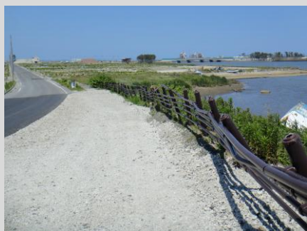
津波による柵の崩壊状況(支柱、ビーム部が屈折している。)
