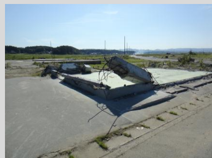
コンクリート基礎のみ残る
