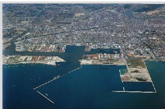
海側から石巻港方向
