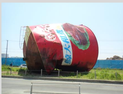
災害時のままの状況である
