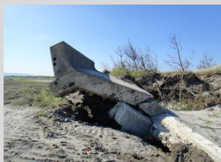
防波堤は海側に転倒している(津波の引潮による崩壊)
