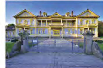
「旧函館区公会堂」ファサード
