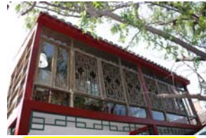
写真-38 増築した部分
