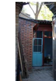
写真-43 改造した部分
