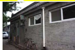
写真-47 公衆トイレ
