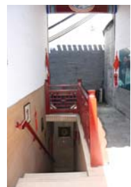
写真-30 増築した部分
