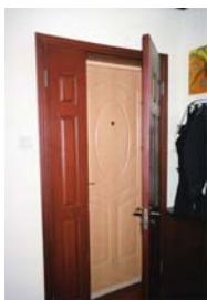
中国の玄関 内側は木製で、室内のドアと変わらないが、外側のドアは木製ドアの表面に鉄板を張り合わせたもの。
